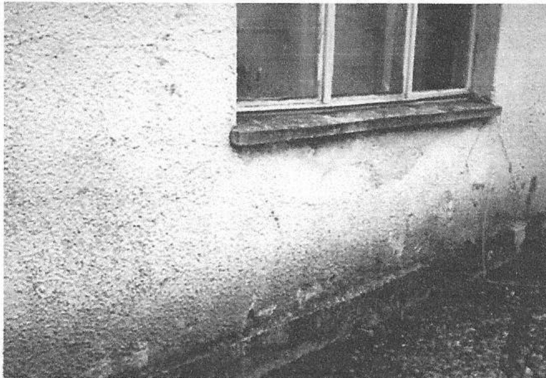
Rys. 15. Widok ściany zewnętrznej budynku przed przystąpieniem do osuszania (fot. własna)
