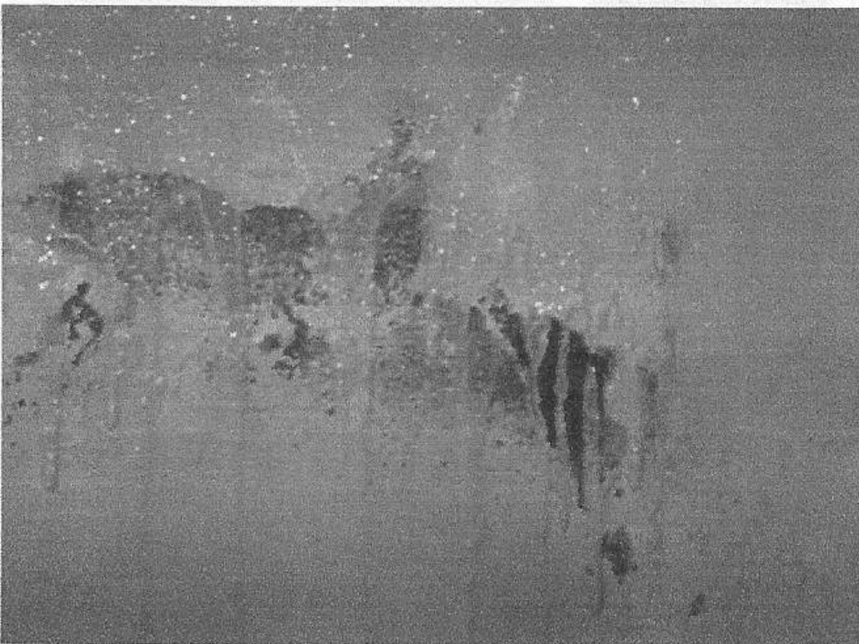
Rys. 12. Widok ściany po kilku sekundach od nałożenia preparatu Hermon – wyrzut nadmiaru elektrolitu (fot. własna)
