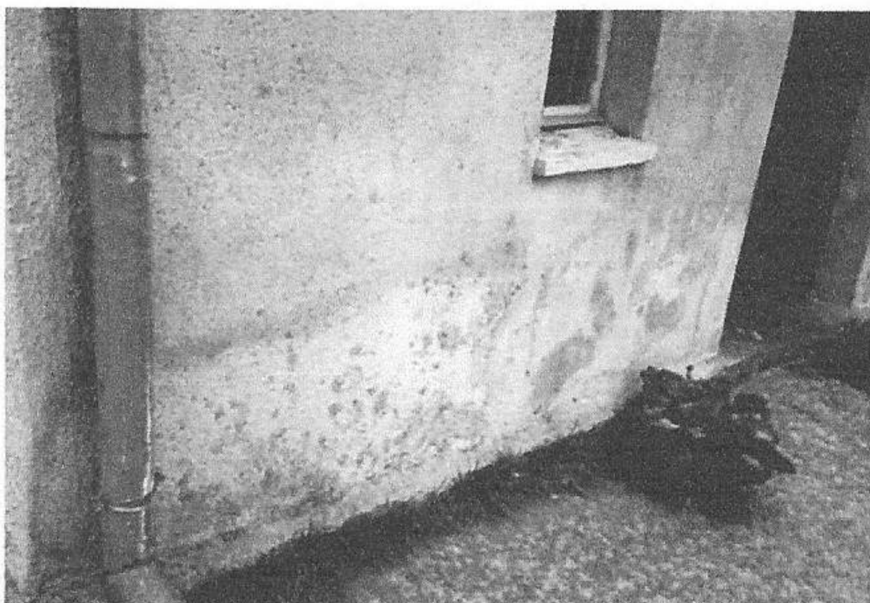
Rys. 16. Widok zewnętrznej ściany budynku po upływie trzech miesięcy od ukończenia prac preparatem Hermon. Mchy i porosty nie zostały usunięte mechanicznie, lecz uległy mineralizacji (fot. własna)
